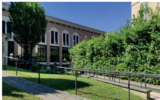
Centro diurno e alloggi - Corte Busca (Lomagna)
